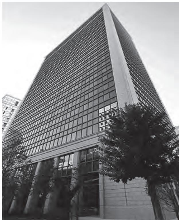
オフィス総貸室面積は 35,417㎡（約 10,713 坪）、浸水対策として、受水槽を地下1階と地上2階に分散配置するほか、防災センターを2階、電気室を3階と屋上、非常用発電機や高置水槽を屋上に配置しています。
