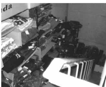
避難管理 1 避難階段に物件存置
