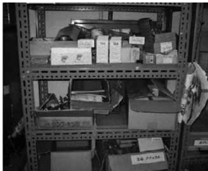
消火設備の管理 1 屋内消火栓設備の操作障害
