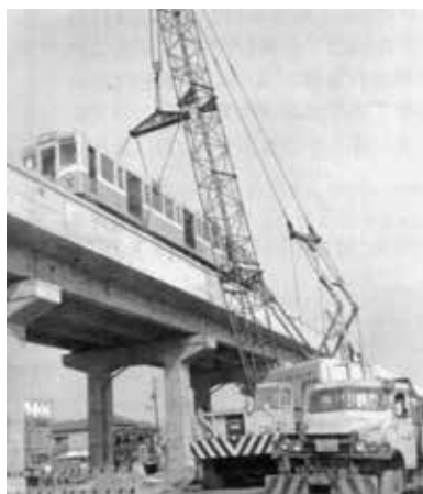
昭和 35 年地下鉄中央線開通
