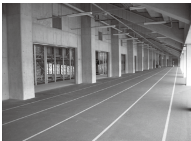
備蓄倉庫のシャッターを開放した状況（常時は閉鎖している）
