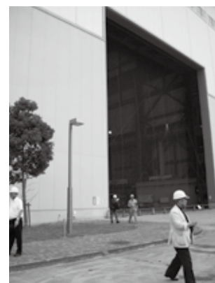
試験する構造物を搬入する入口
