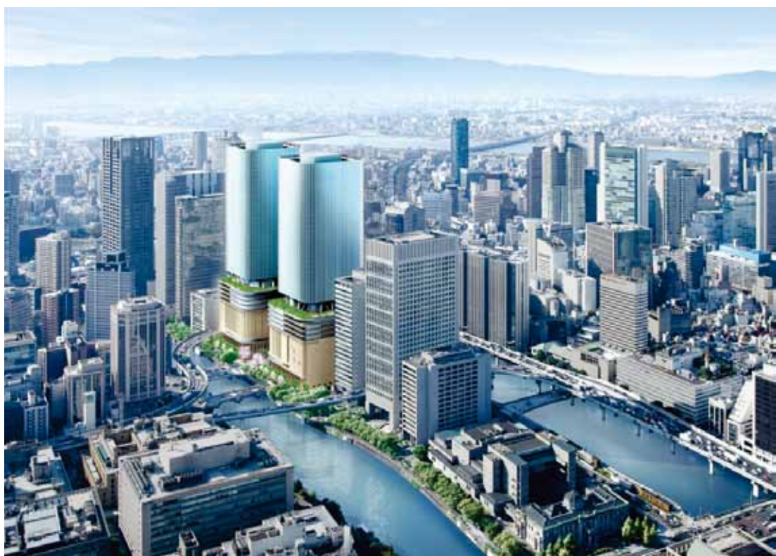
2012 年秋竣工予定の中之島フェスティバルタワー（手前）。 奥は 2018 年頃竣工予定の西地区
