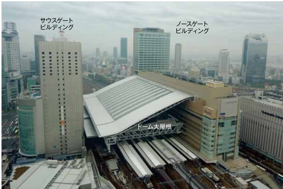
大阪ステーションシティ全景
