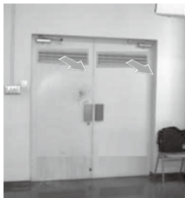
ドアガラリ上部 (改修後)
