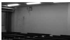
現状 壁付換気扇
