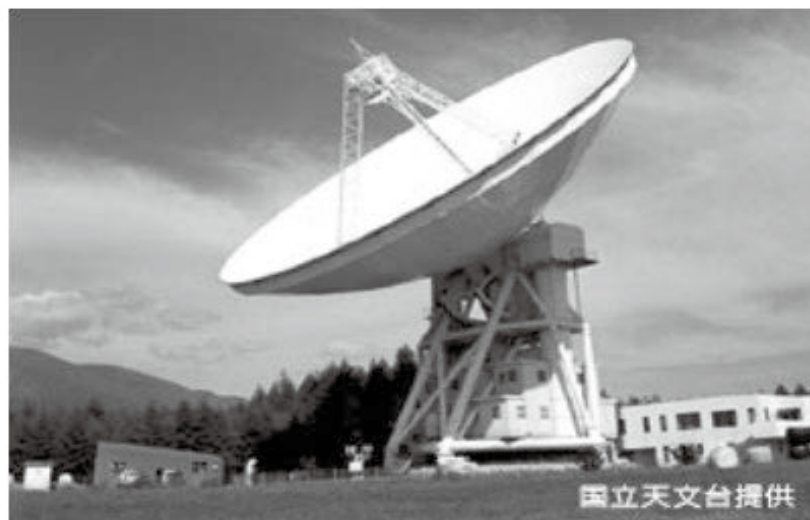
直径45mのパラボラアンテナを持つ電波望遠鏡
